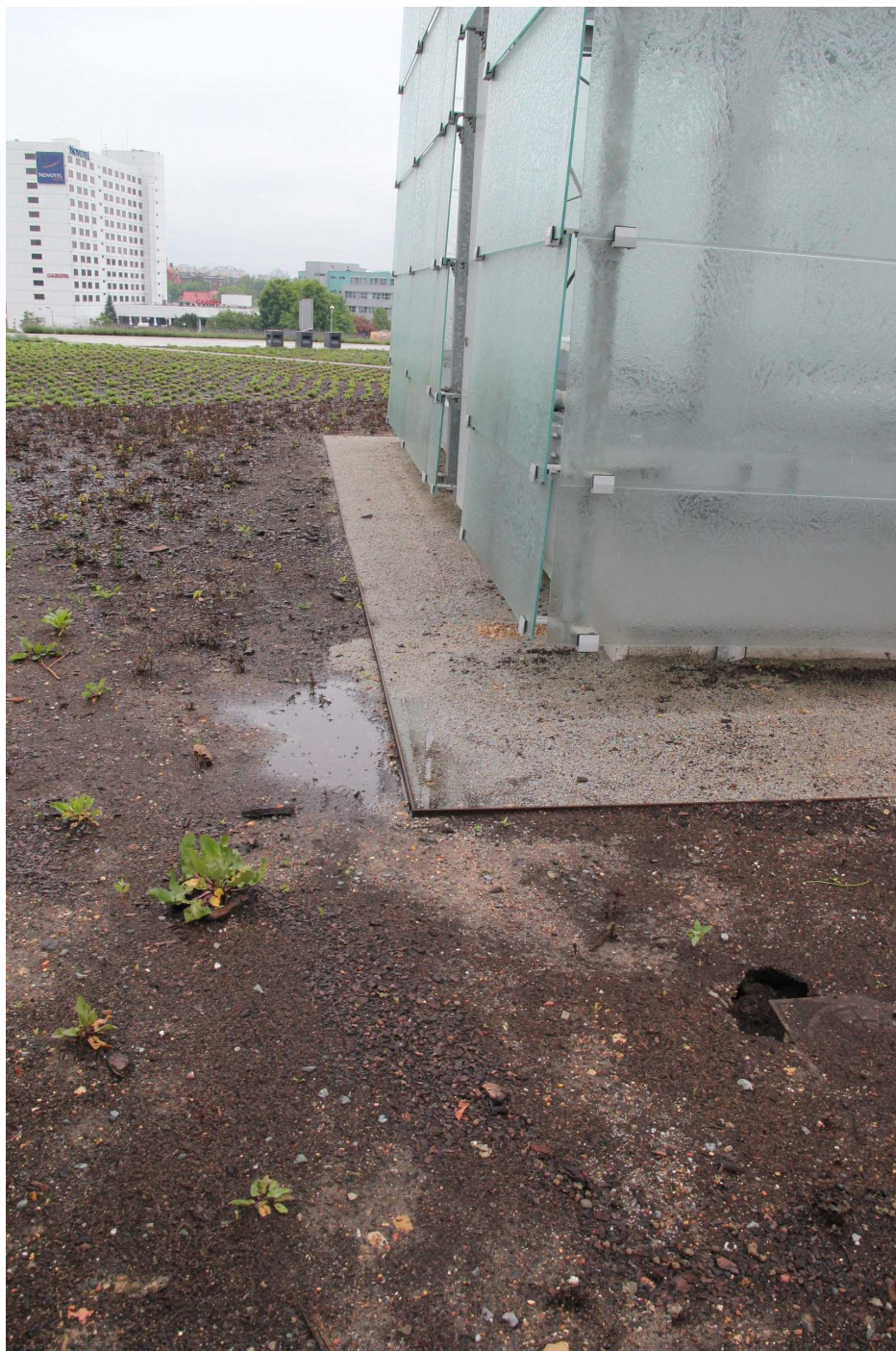
Zdjęcie nr 30a. Widok na naroże szklanego boksu nr 1. Zdjęcie wykonane bezpośrednio po opadach deszczu. Widoczne niecki wypełnione wodą, naniesiony żwir oraz całkowite nasączenie substratu wodą. Degradacja roślin niemal 100%.
