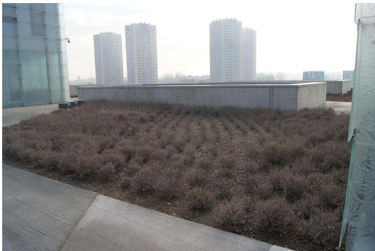
Zdjęcie nr 13. Widok od strony budynku holu głównego na budynek administracyjny i szyby. Widoczna degeneracja roślin i pas zniszczeń w miejscu głównej trasy przepływających wód deszczowych.
