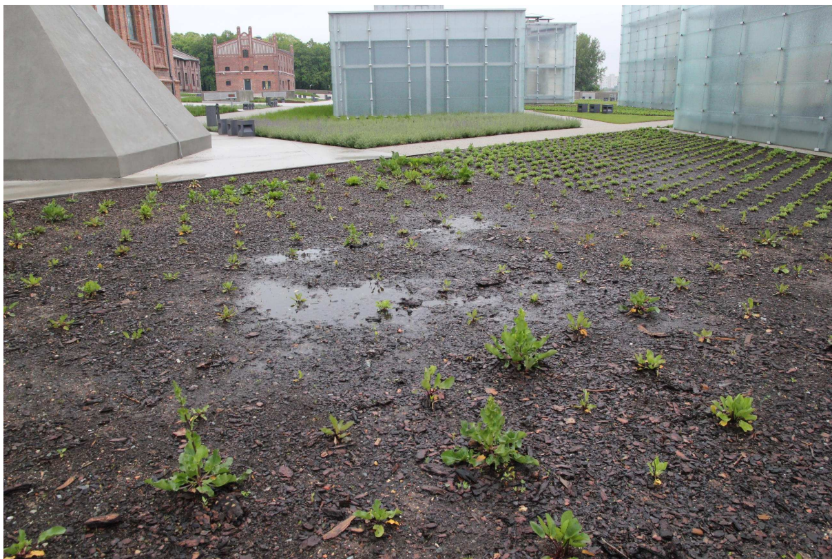
Zdjęcie nr 30b. Widok na naświetla (szklane boksy 1,2,3,4) od strony ścieżki w zachodniej granicy terenu Muzeum. Zdjęcie wykonane bezpośrednio po opadach deszczu. Widoczne niecki wypełnione wodą, naniesiony żwir oraz całkowite nasączenie substratu wodą. Degradacja roślin niemal 100%.
