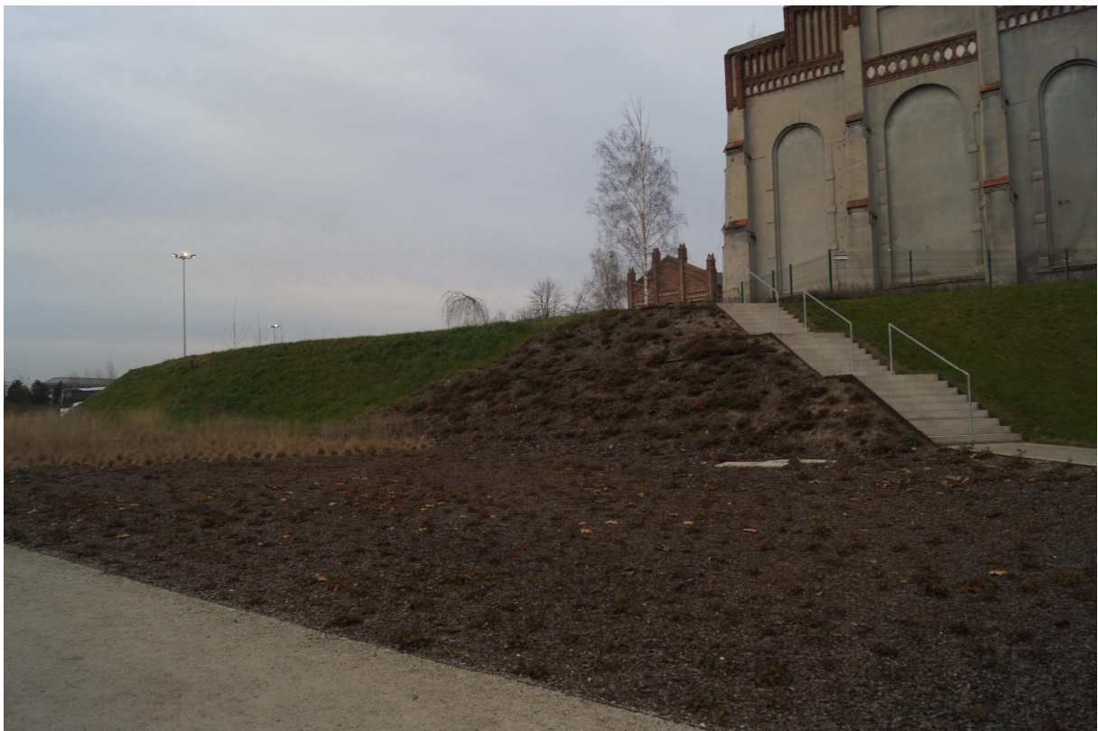
Zdjęcie nr 33. Widok na skarpę na granicy obszaru Muzeum od strony północnej. Widoczna różnica poziomów terenu oraz bardzo duża degradacja roślin z powodu zastoju wód opadowych. Przy schodach widoczne naniesienia piachu i żwiru z wyżej położonego terenu.
