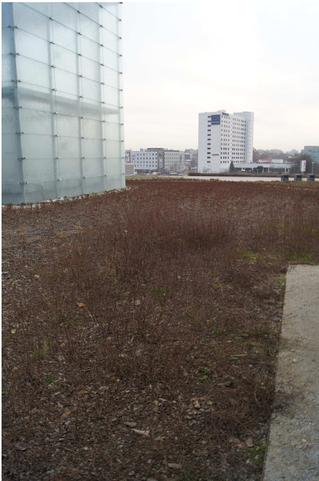
Zdjęcie nr 31. Widok ze szklanego boksu nr 1 na szklany boks nr 2. Zdjęcie wykonane bezpośrednio po opadach deszczu. Widoczne niecki wypełnione wodą, naniesiony żwir oraz całkowite nasączenie substratu wodą. Degradacja roślin niemal 100%.
