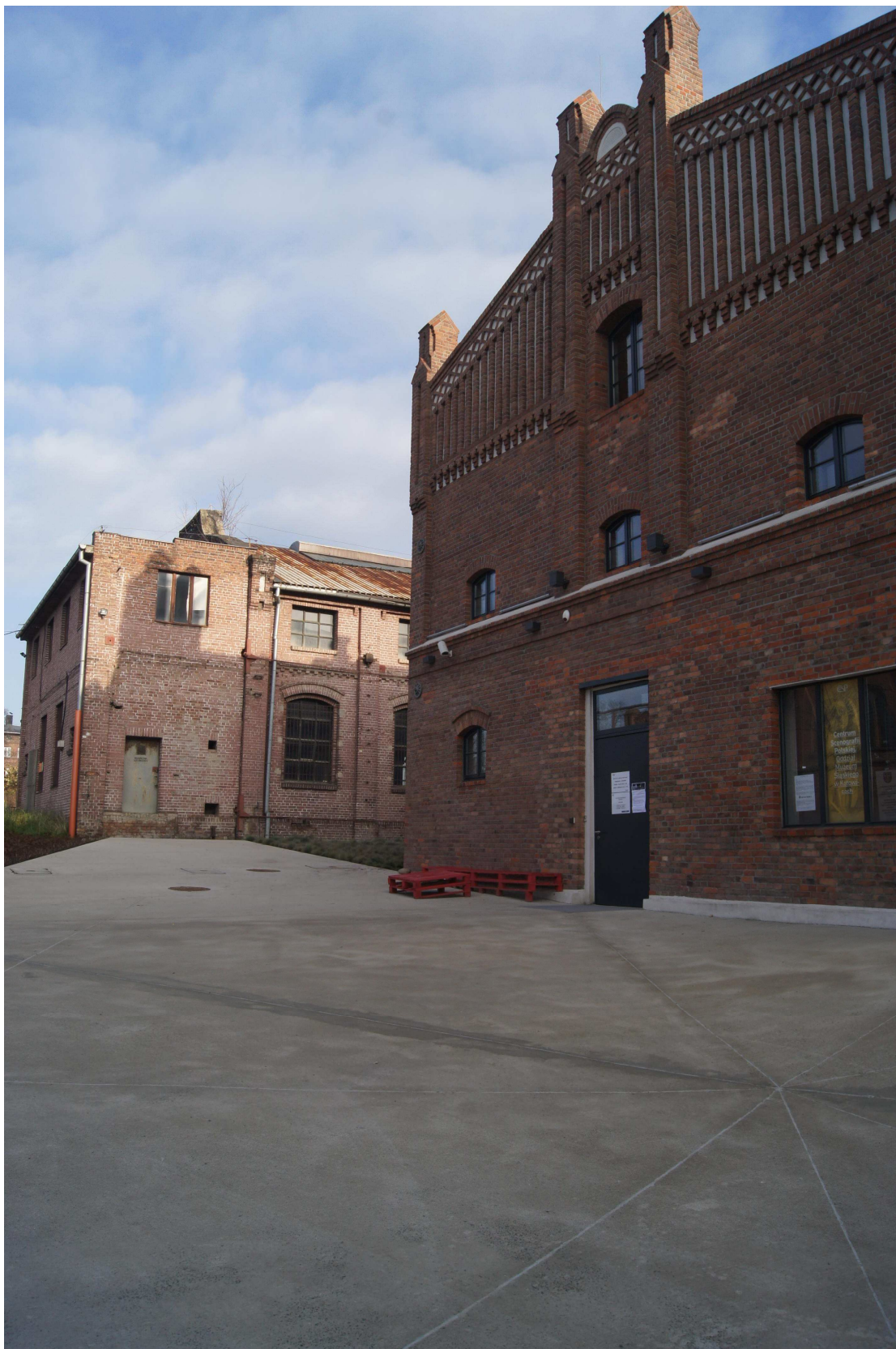
Zdjęcie nr 3. Ukształtowanie betonowej powierzchni terenu w okolicy budynku MS-15. Zilustrowanie wielkości i kierunku spadku terenu. Widoczna niecka w miejscu zbiegu płyt betonowych, bez wpustu deszczowego.
