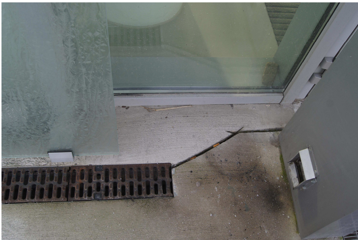
Zdjęcie nr 9. Odwodnienie liniowe przy wejściu głównym do budynku administracyjnego. Widoczne „odprowadzenie” wód wyciętą w betonie szczeliną w kierunku wpustu pod wycieraczką systemową.
