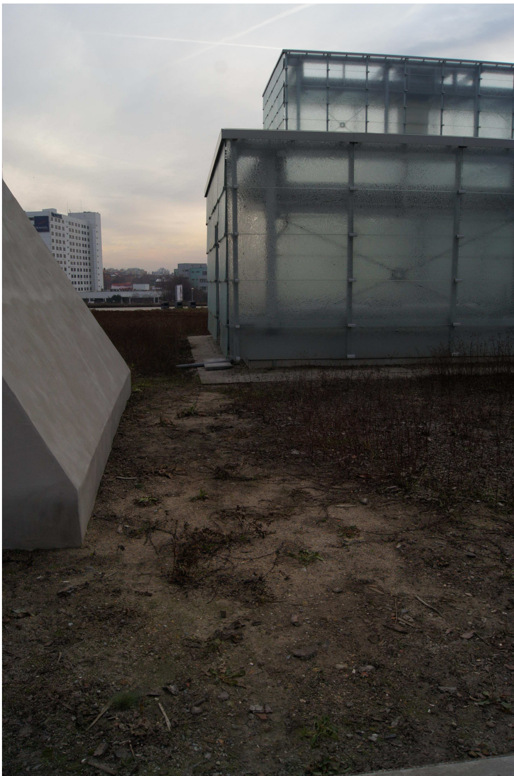
Zdjęcie nr 29. Widok na naświetle od fundamentów szybów górniczych. Widoczna całkowita degradacja roślinności, naniesiony żwir oraz w drugim planie rura spustowa budynku naświetla wyprowadzona na teren.
