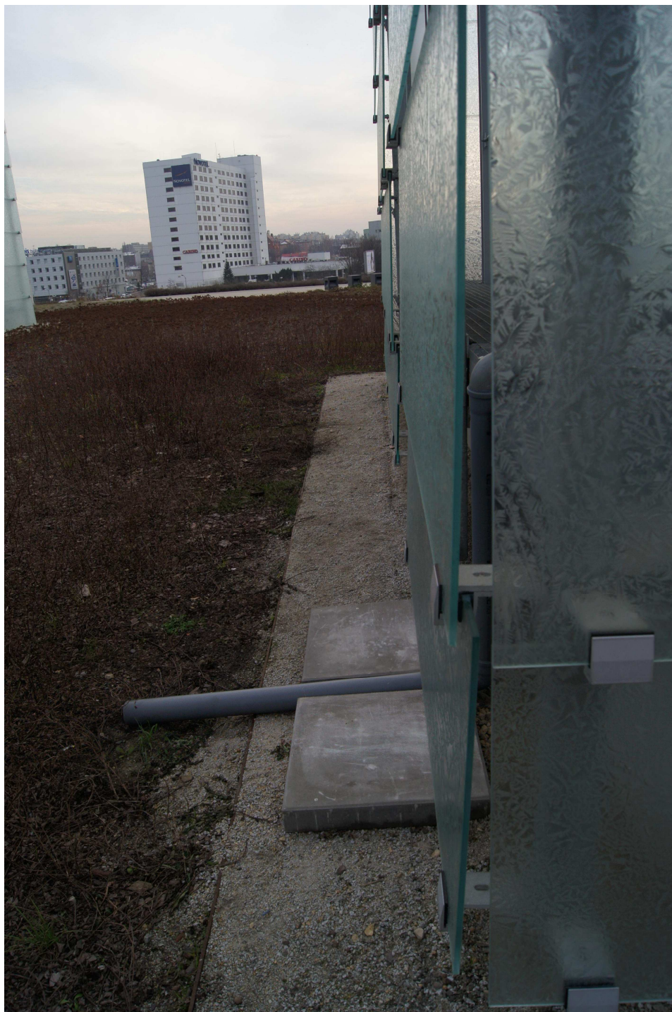
Zdjęcie nr 30. Widok na naświetle od fundamentów szybów górniczych. Zbliżenie na rurę spustową budynku naświetla wyprowadzoną na teren. Widoczna degradacja roślin i naniesiony zwir na teren zielony.
