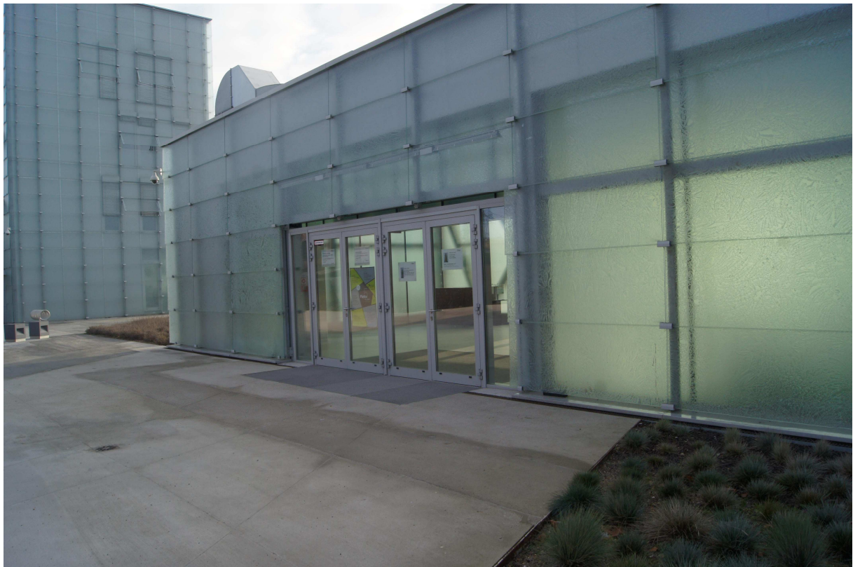
Zdjęcie nr 16. Wejście do budynku holu centralnego. Widok na wycieraczkę systemową przy wejściu głównym, odwodnienia liniowe oraz Wpust w dachu budynku podziemnego. Widoczne zawilgocenia w obszarach ścieżek i wpustu.
