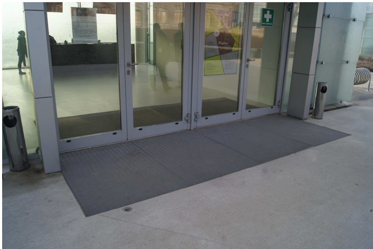
Zdjęcie nr 10. Wycieraczka systemowa przy wejściu głównym do budynku administracyjnego. Widoczne „zawilgocenie przy lewym narożu wycieraczki spowodowane brakiem należytego odprowadzenia wód z odwodnienia liniowego (nawiązanie do rys.9)
