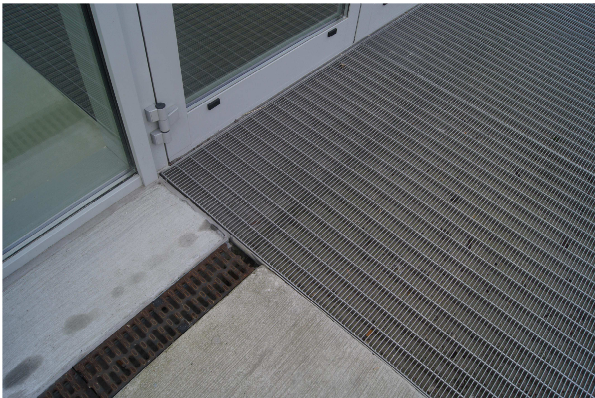
Zdjęcie nr 14. Wejście do budynku administracyjnego. Zilustrowanie sposobu odprowadzenia wód deszczowych z odwodnienia liniowego (szczelina widoczna pod kratką wycieraczki systemowej)
