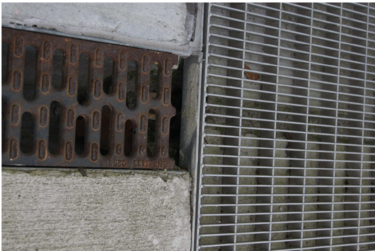
Zdjęcie nr 15. Wejście do budynku administracyjnego. Sposób odprowadzenia wód deszczowych z odwodnienia liniowego – szczegół, zilustrowanie braku drożności połączenia
