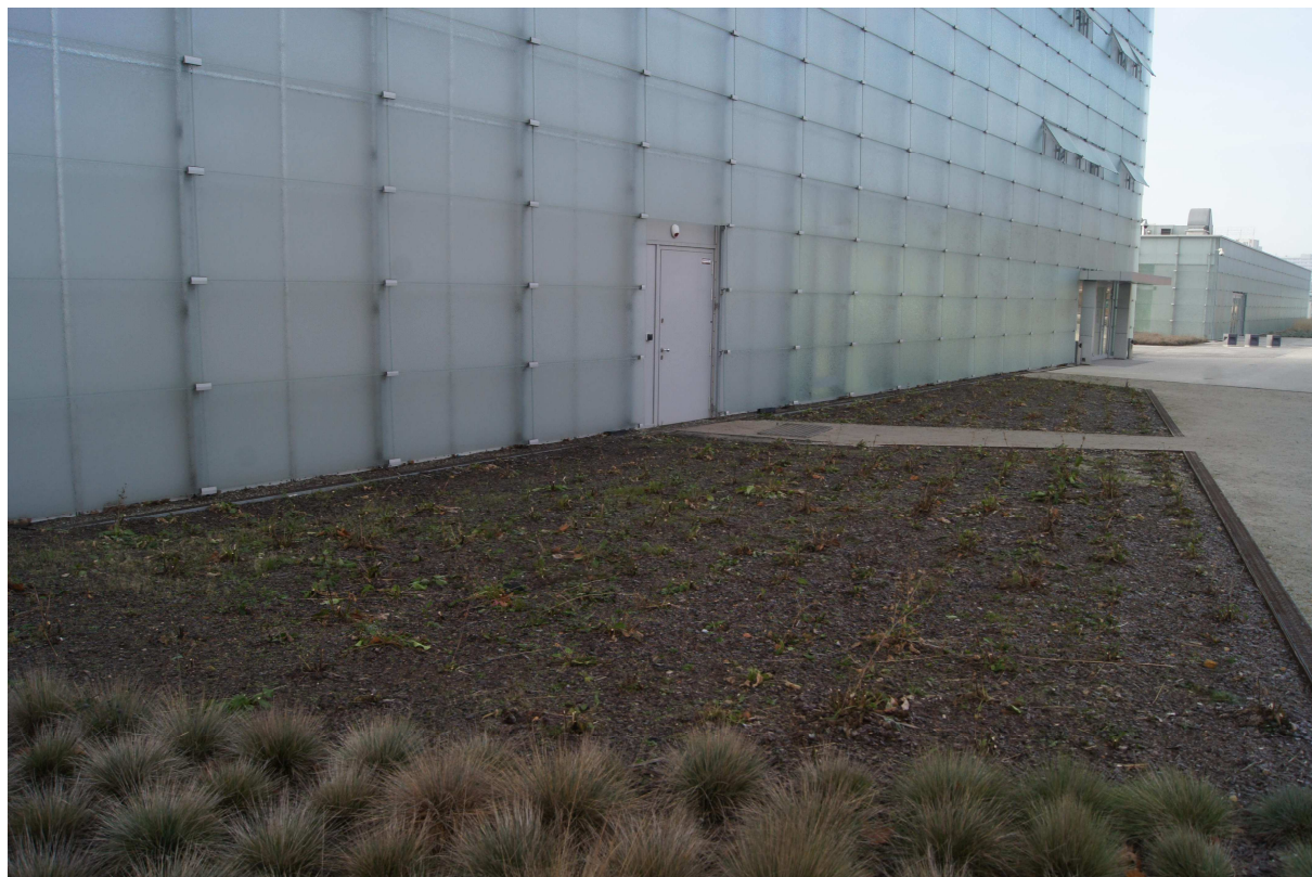
Zdjęcie nr 6. Teren zielony przy ścianie frontowej budynku administracyjnego. Widoczne duże zawilgocenie substratu i obumarcie nasadzonych roślin.
