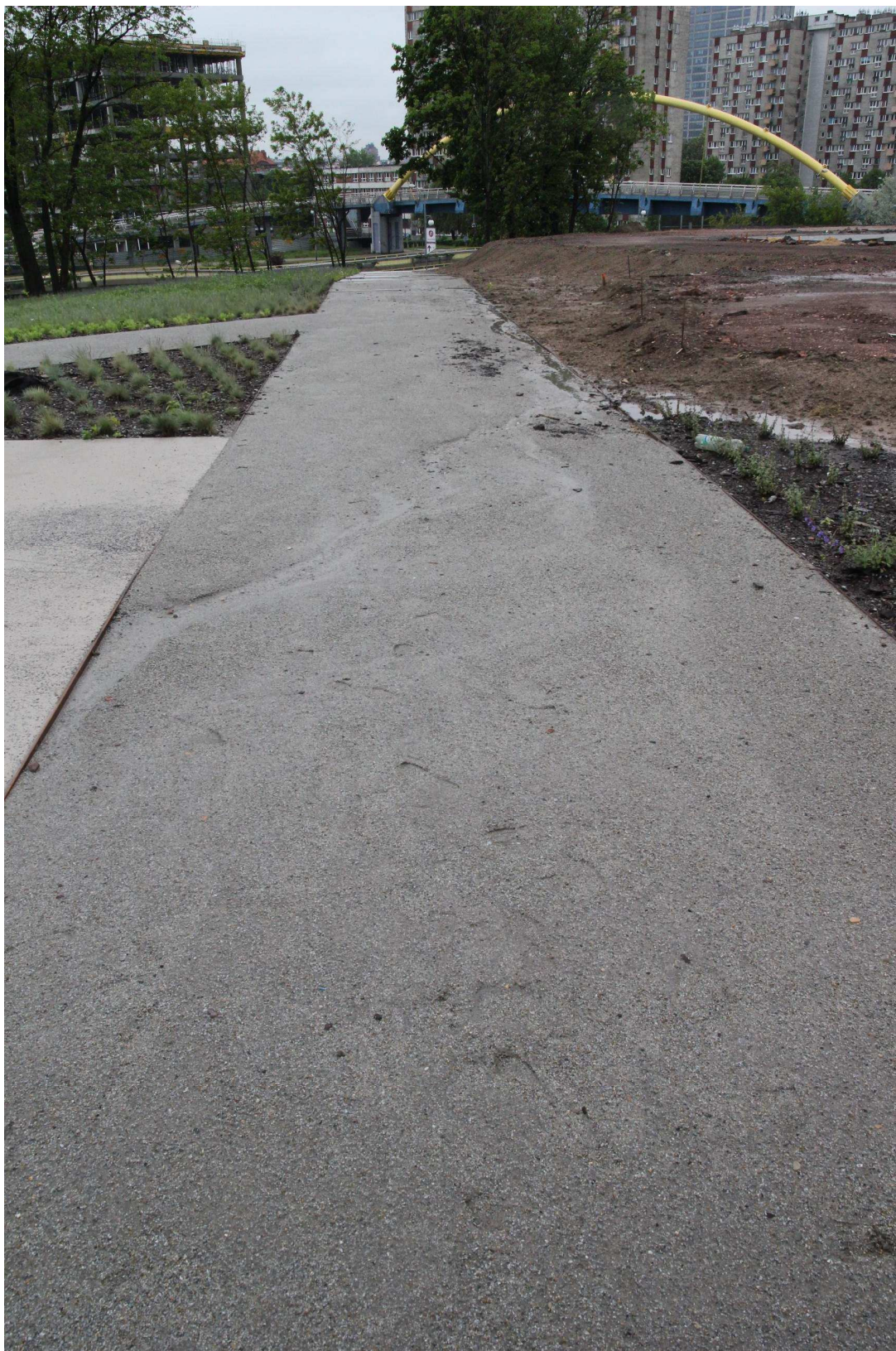
Zdjęcie nr 35a. Widok na granicę obszaru Muzeum od strony zachodniej. Widok na schody na wprost. Widoczne zniszczenia ścieżki żwirkowej, wymywanie żwiru W poprzek ścieżki przez przepływającą wodę deszczową. Widoczny napływ wód od strony parkingu przy zachodniej granicy inwestycji (parking poza granicami inwestycji) Degradacja roślin w rowie.
