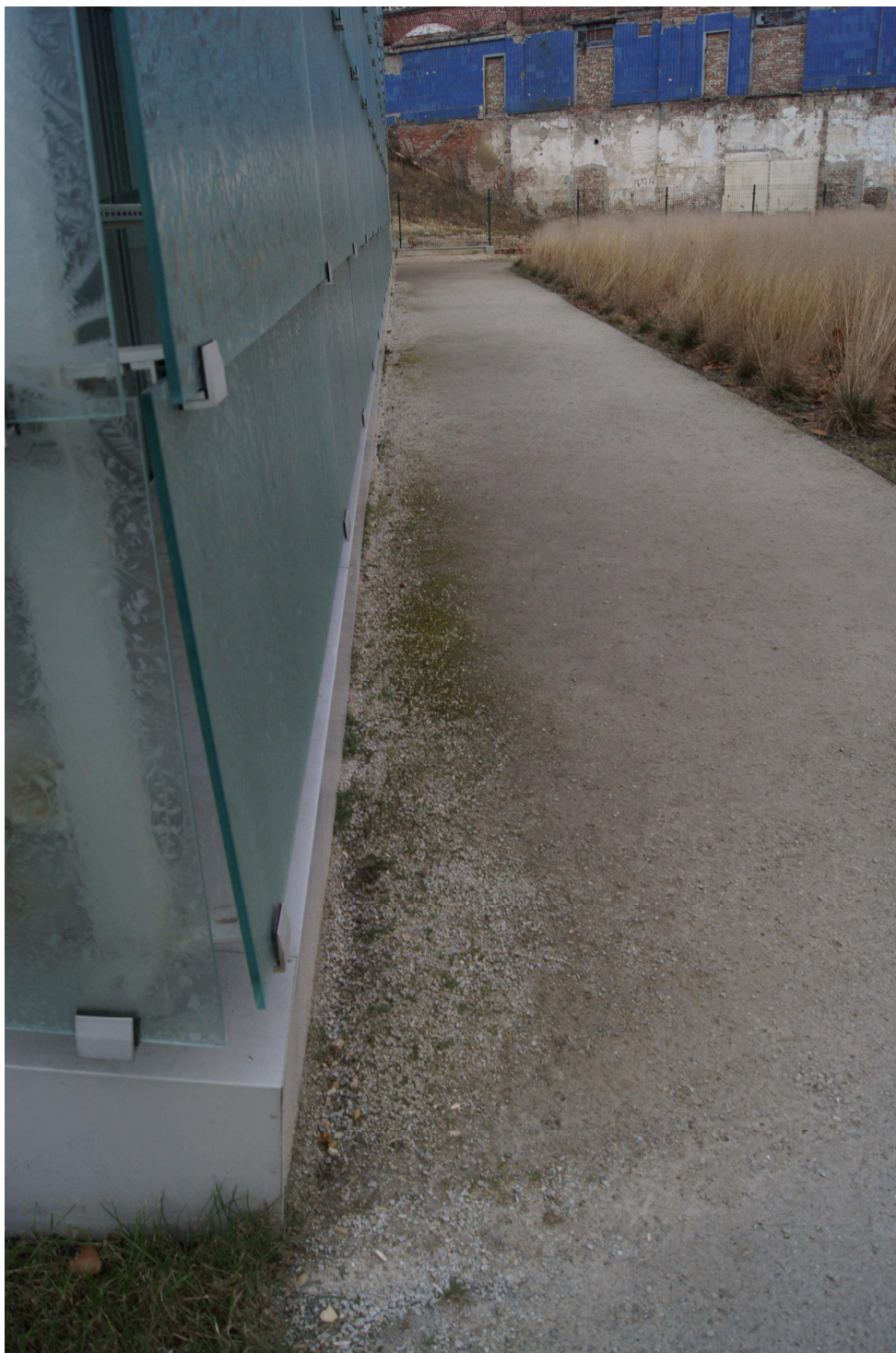
Zdjęcie nr 26. Widok na naroże budynku MS-CH od strony dojścia od szybów górniczych. Zbliżenie widocznego omszenia ścieżki wzdłuż elewacji budynku spowodowanego zastojami wody deszczowej.
