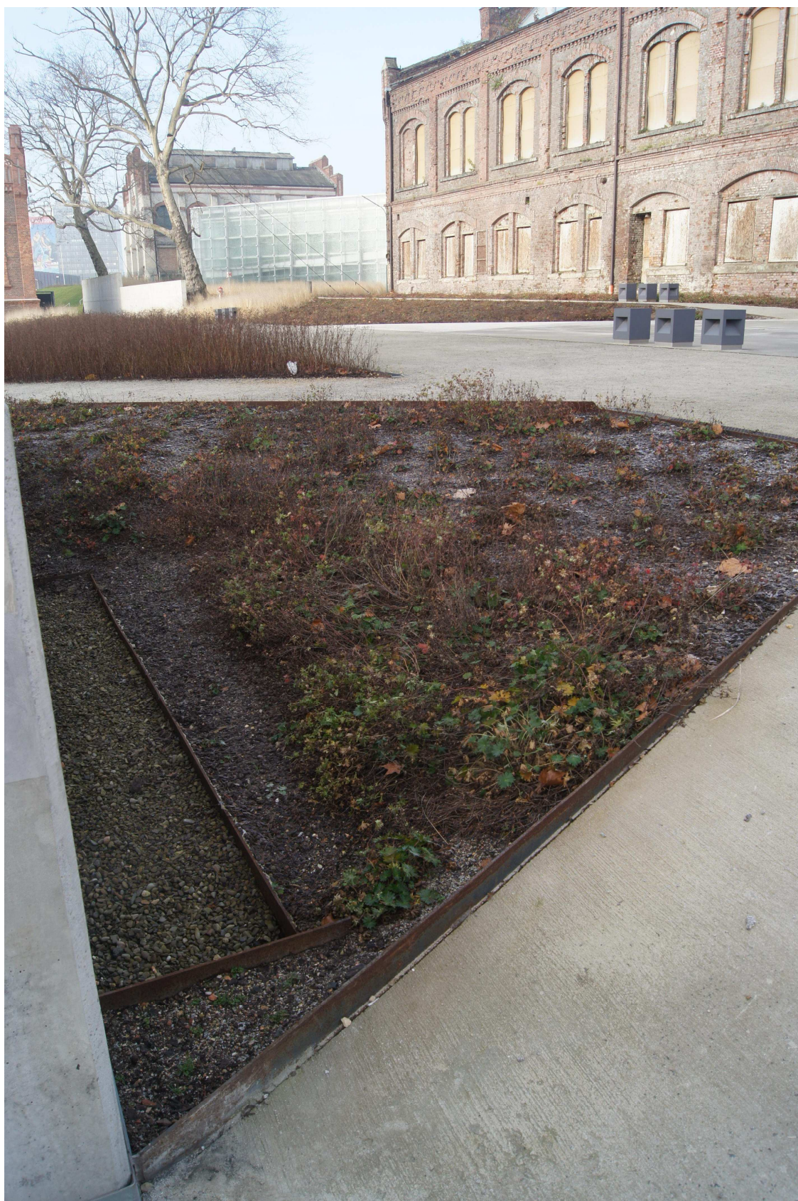
Zdjęcie nr 7. Lokalizacja wysokościowa terenowej czerpni powietrza z klatką schodową przy ścianie frontowej budynku administracyjnego. Zilustrowanie wielkości i kierunku przepływu wód deszczowych. Widoczne duże zawilgocenie Substratu i degradacja nasadzeń spowodowana zawilgoceniem.
