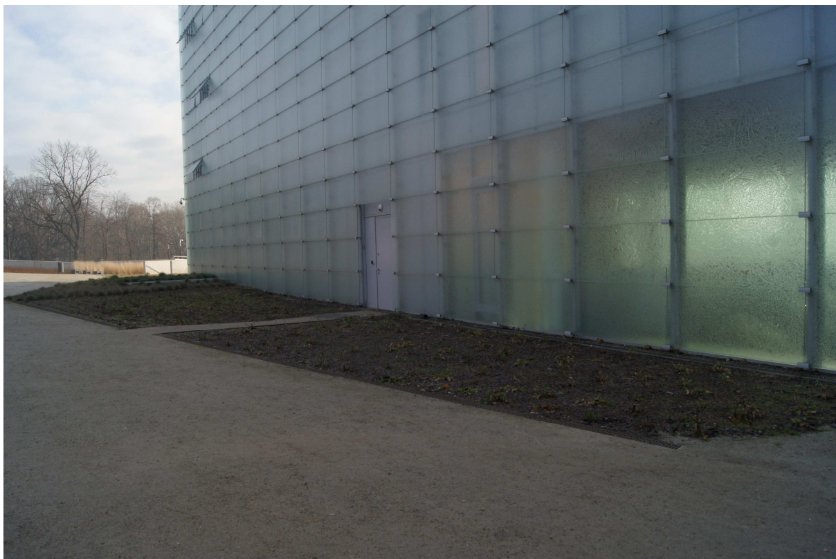
Zdjęcie nr 8. Teren zielony przy ścianie frontowej budynku administracyjnego. Widoczne duże zawilgocenie substratu i obumarcie nasadzonych roślin. Widoczny napływ żwiru na obszar substratu.
