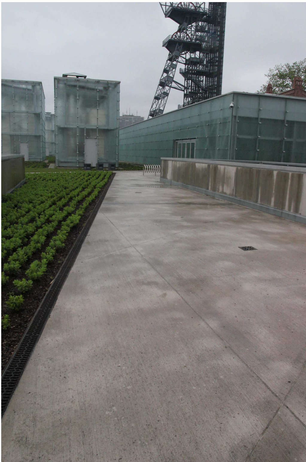
Zdjęcie nr 39. Widok na szklany boks nr 6 i 5 oraz budynek holu centralnego od strony budynku administracyjnego. W drugim planie widoczny szyb górniczy. Zdjęcie wykonane bezpośrednio po opadach deszczu. Widoczne zawilgocenie ściany szybu, nagromadzenie wody przy ścianie szybu. Widoczne również wpusty deszczowe. Brak przeciwspadków przy wpustach.
