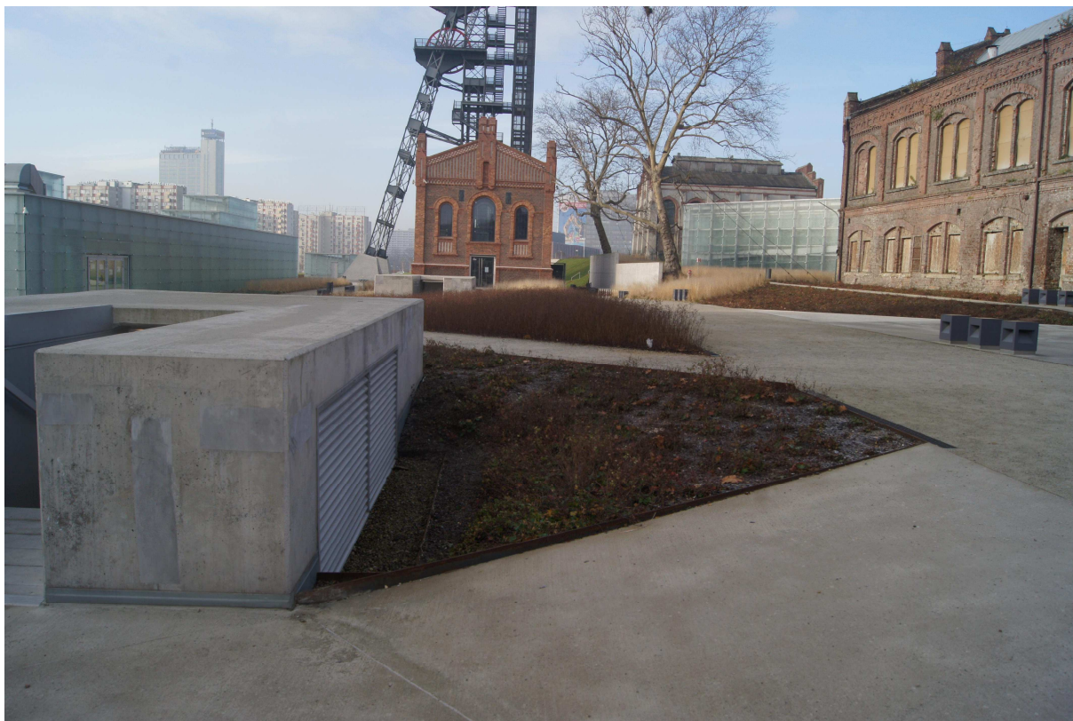
Zdjęcie nr 2. Lokalizacja wysokościowa terenowej czepni powietrza z klatką schodową przy ścianie frontowej budynku administracyjnego. Zilustrowanie wielkości i kierunku spadku terenu. Widoczne duże zawilgocenie substratu.
